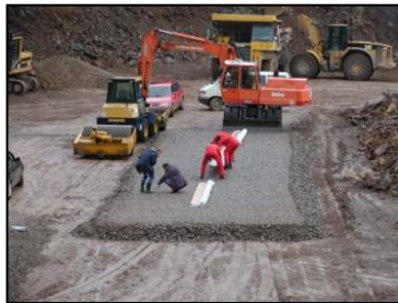
Bild 1: Ausbreiten des Geokunststoffes
