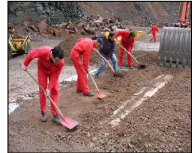
Bild 4: Ausbau des Geokunststoffes
